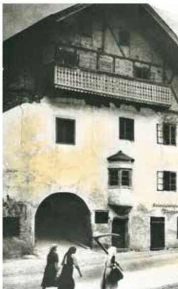
Erker vom Ellerhaus, Pfunds
